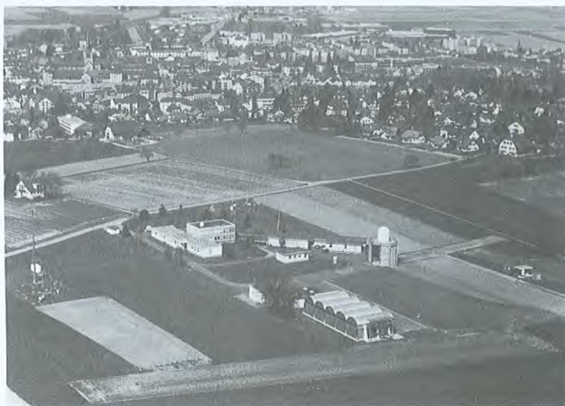
La Station aérologique de Payerne aujourd'hui: vue aérienne prise depuis le sud avec en arrière plan, la ville de Payerne. Au centre, les bâtiments principaux et le radome du radar de poursuite du radiosondage. Au premier plan, les dépôts et les garages. Sur la gauche et derrière les bâtiments principaux, les terrains de mesures météorologiques. (photo DMF, Payerne)
